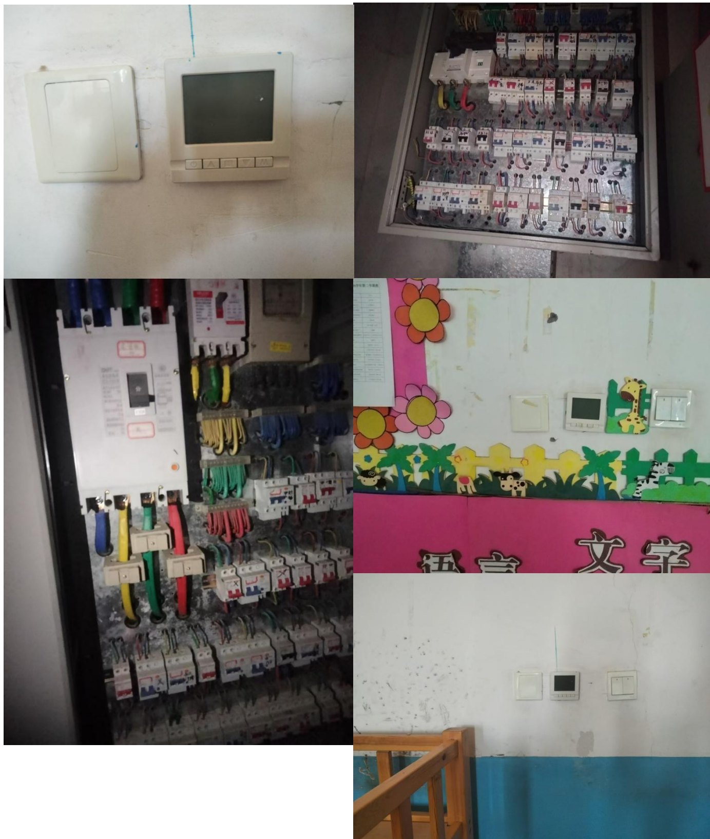
附件 4：现场勘查照片
